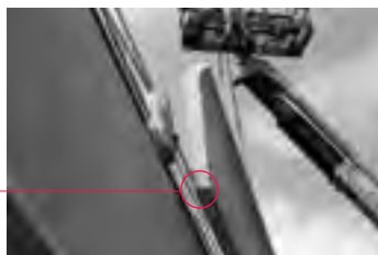
❸ Elevació y colocació del panel: introducció de la mènula ERCOLE en la cavitat de la scatola vite.
