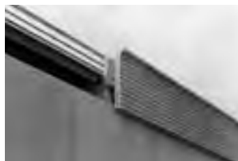
❸ Elevació y colocació del panel: introducció de la mènula ERCOLE en la cavitat de la scatola vite.
